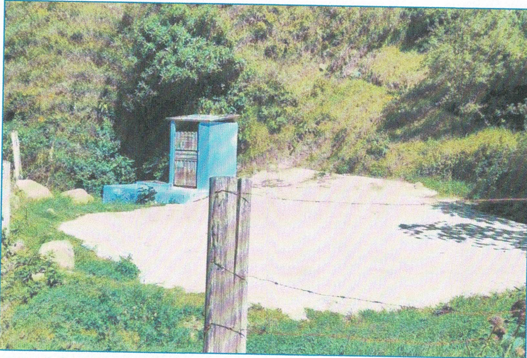
Imagen 4. Captación de Amaroyuc
