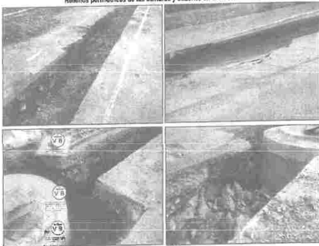
Imágenes n.º 12, 13, 14 y 15 Rellenos perimétricos de las cámaras y buzones en la vía evitamiento.
