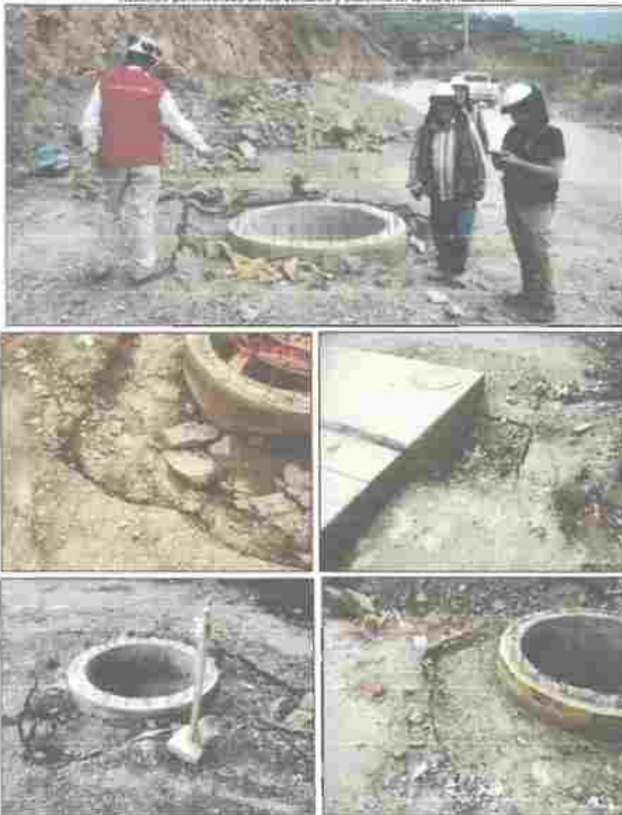
Imágenes n.º 7, 8, 9, 10 y 11 Rellenos perimétricos de las cámaras y buzones en la vía evitamiento.
